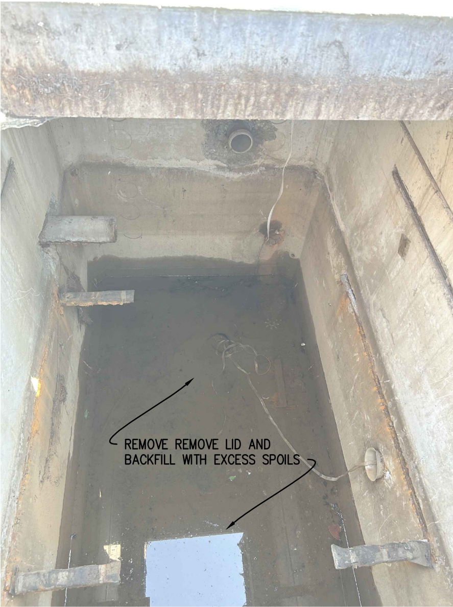
11 9'x5'x6' EXISTING SUBSTATION VAULT SCALE: N.T.S.
