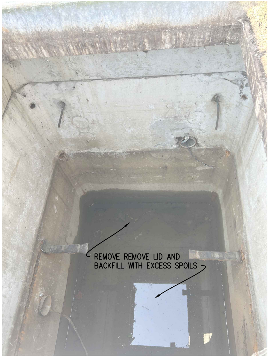
10 9'x5'x6' EXISTING SUBSTATION VAULT SCALE: N.T.S.
