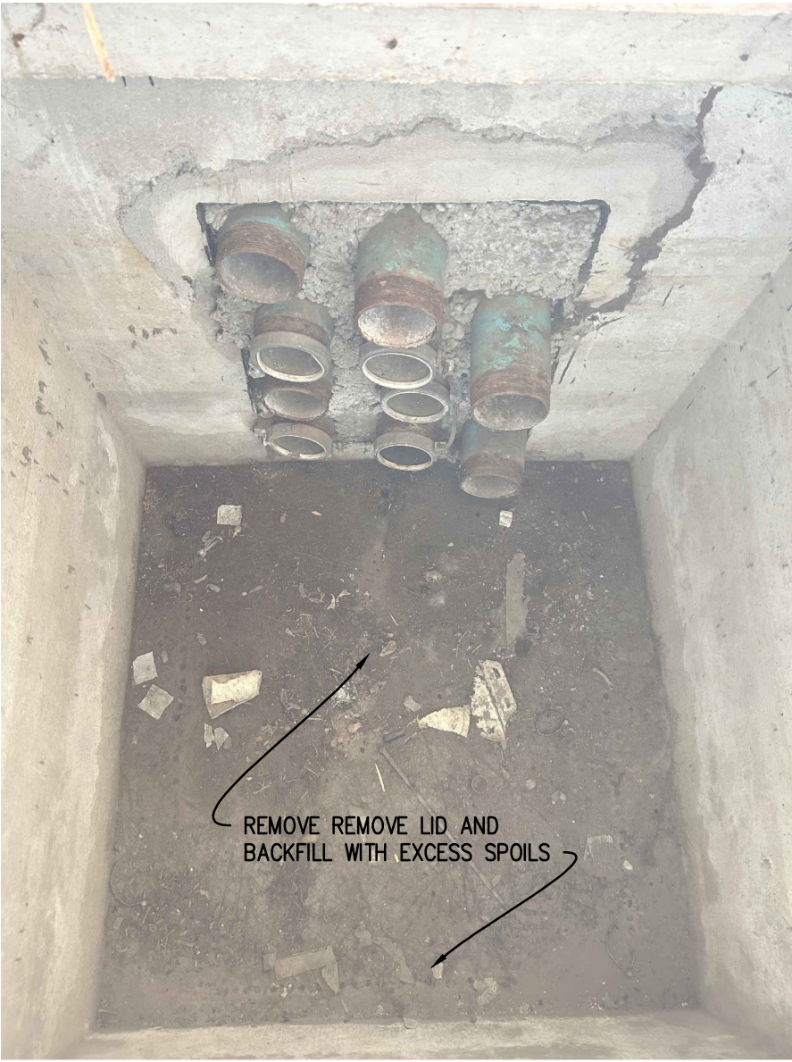
07 4'x4'x4' VAULT INSIDE METAL SHED SCALE: N.T.S.
