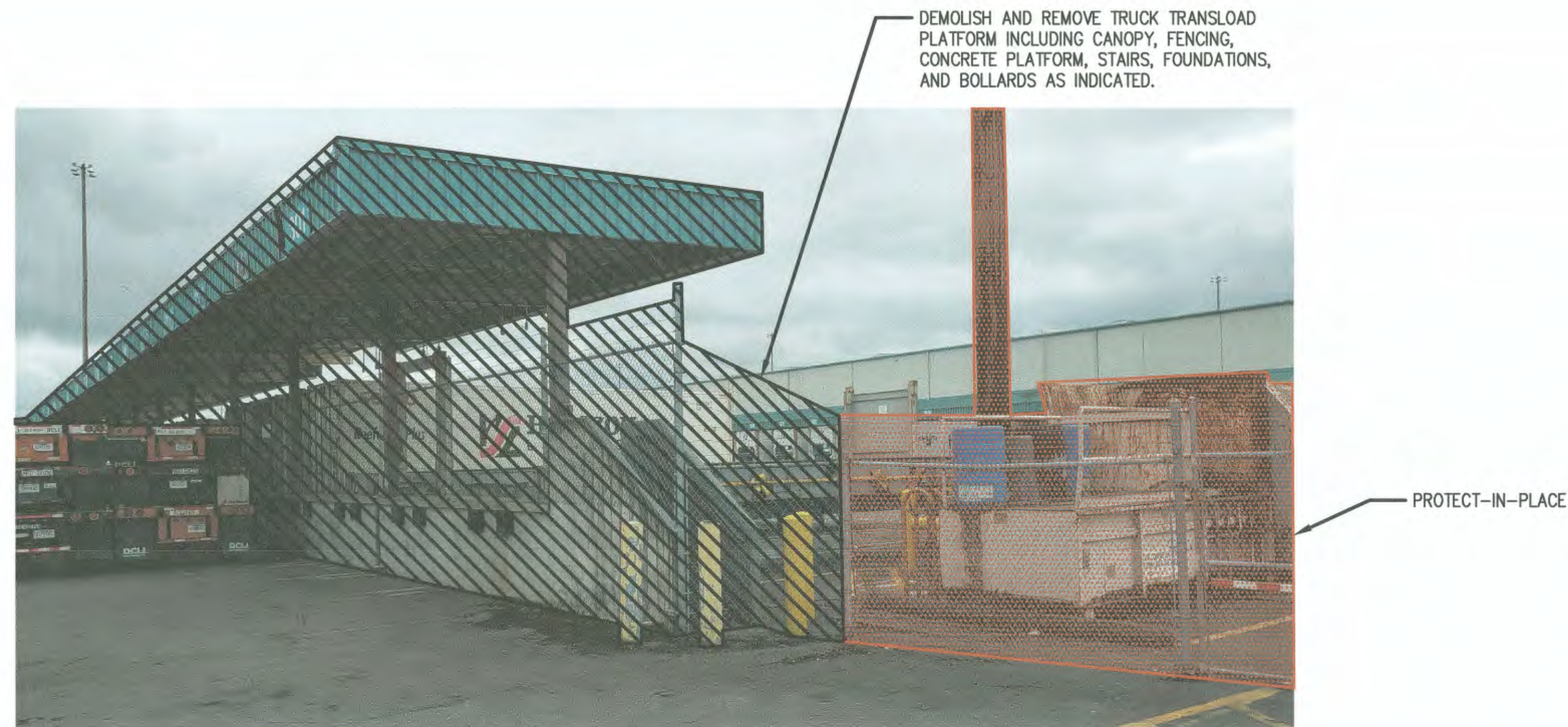
P1 DEMOLITION PHOTO 1 D1.1 SCALE: NTS
