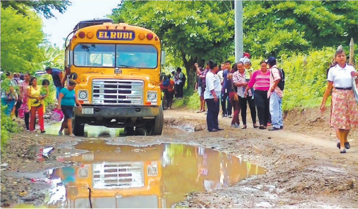
El conductor del bus de la comunidad Nandarola pide a los pasajeros que se bajen en un tramo malo para evitar que la unidad se vuelque con los pasajeros dentro debido al mal estado de la vía.
