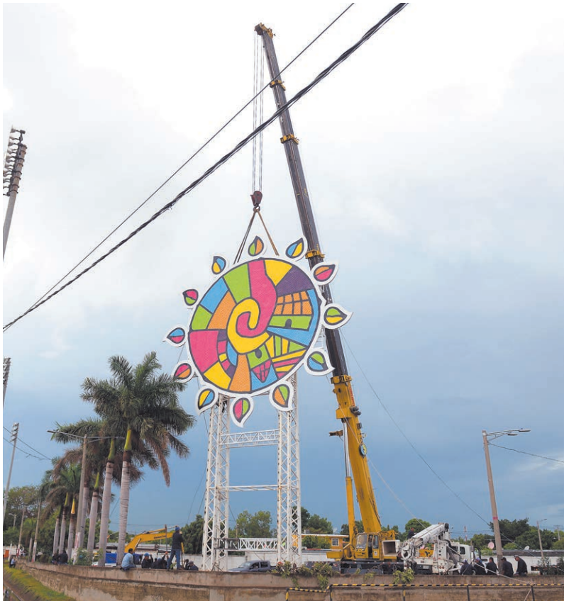
Un gran sol metálico colorido y luminoso se colocó en el lado este de la Plaza de la Fe, que requirió ser sostenido por una gran grúa mientras era sellada la base con cemento.
