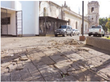
La parroquia Santiago en Jinotepe será restaurada con el apoyo de la feligresía.
