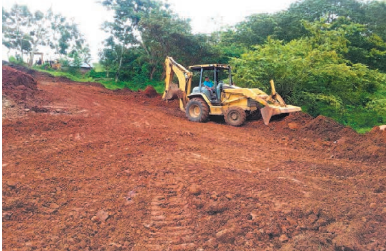
Con el módulo de construcción adquirido por la Alcaldía de Camoapa se ha dado respuesta en el mantenimiento de caminos.
