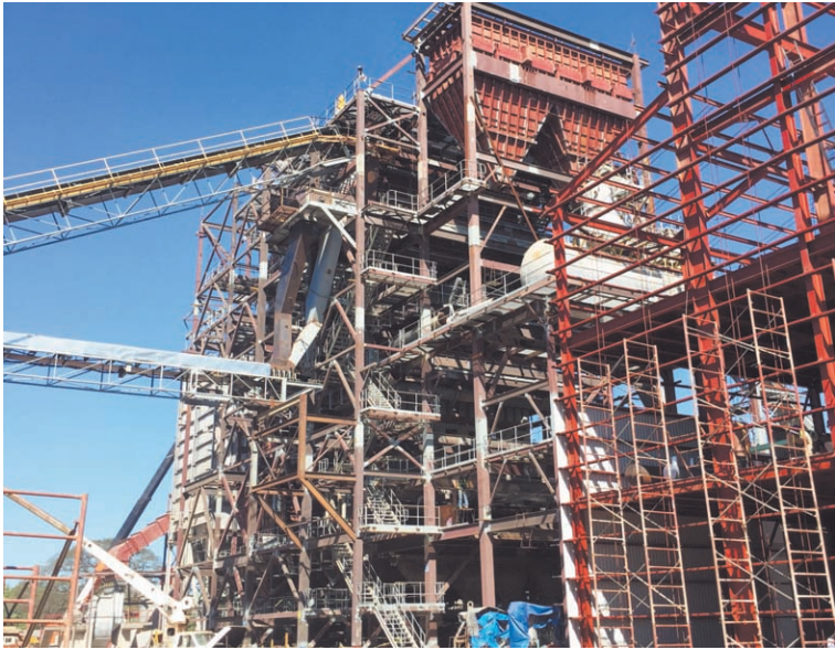
En el Ingenio Montelimar se realizan los trabajos para la instalación de la nueva caldera que costó 15 millones de dólares.
