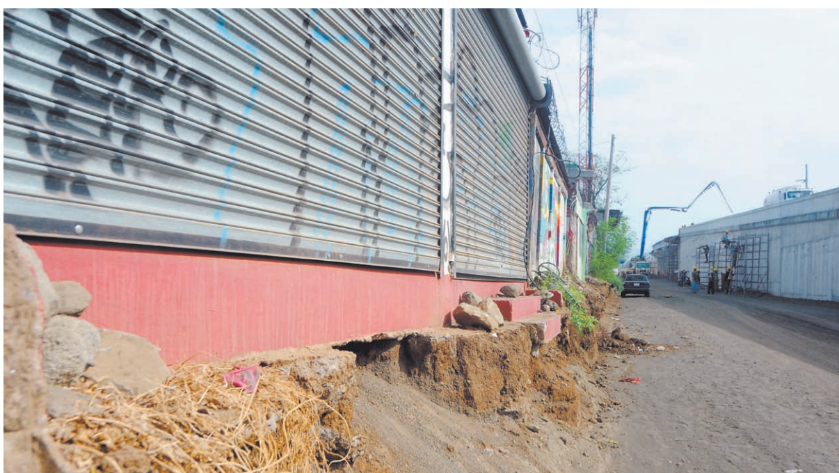
Equipos pesados de la Alcaldía de Managua han trabajado junto a los muros de viviendas en Rubenia al profundizar el nivel de una de las calles de salida que tendrá el paso a desnivel que la comuna construye
