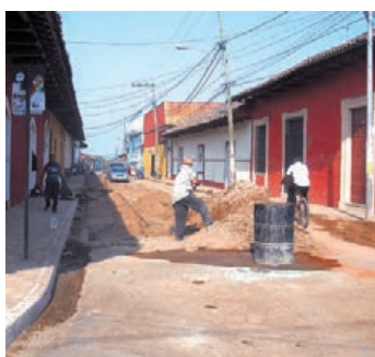
Los trabajos posiblemente se extiendan hasta mediados del año que viene.
