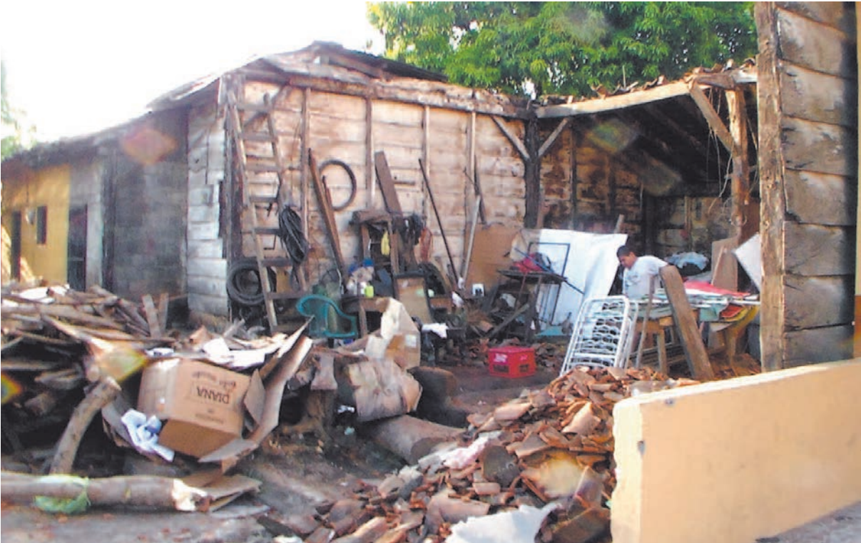
La casa de madera centenaria se derrumbó a la 1:00 de la tarde del domingo en el barrio El Calvario, de Chinandega. Por fortuna no hubo víctimas humanas.
