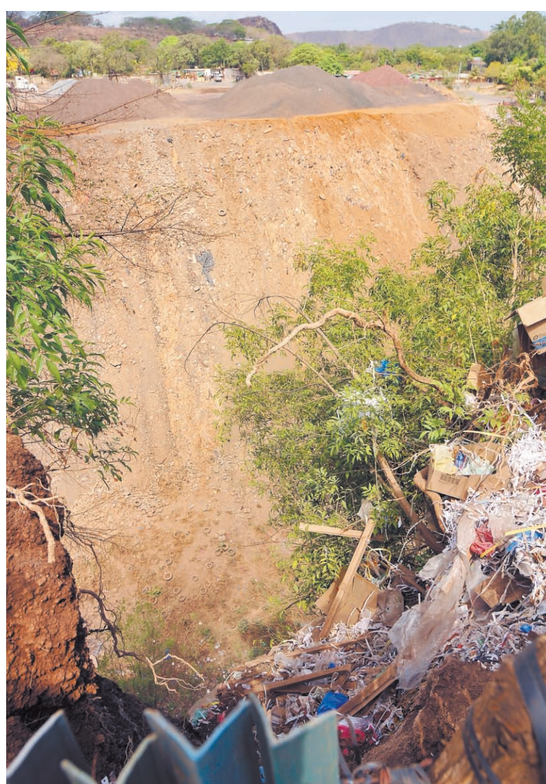
Vista desde el patio trasero de una de las viviendas evacuadas en El Hoyo, sector de Batahola Sur, Managua.
