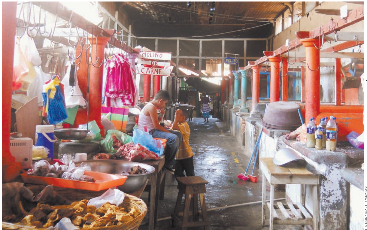
Las autoridades del departamento de Granada están alertas por la vieja estructura del mercado, donde puede darse una eventual evacuación según la emergencia.
