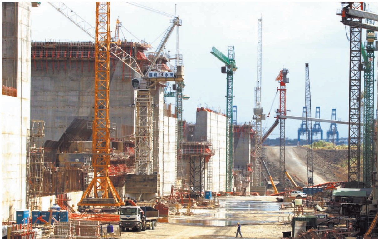
Las obras de ampliación del canal, para permitir la travesía de supercargueros con hasta 12,000 contenedores (el doble de la capacidad actual) deberán tener un impacto directo en la economía estadounidense.
