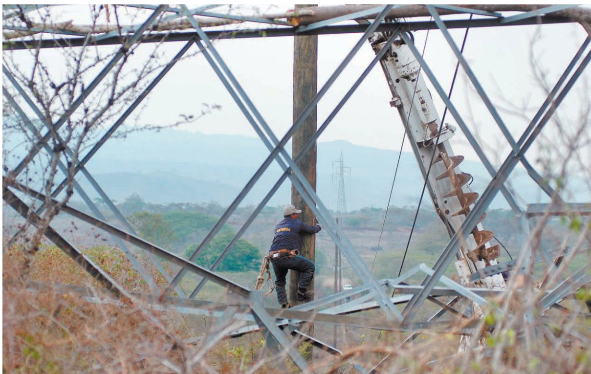
Las Pequeñas Centrales Hidroeléctricas facilitan electricidad a las comunidades donde no llegan las redes de Enatrel. El sesenta por ciento de las acciones son de clientes y consumidores de las comunidades rurales.
