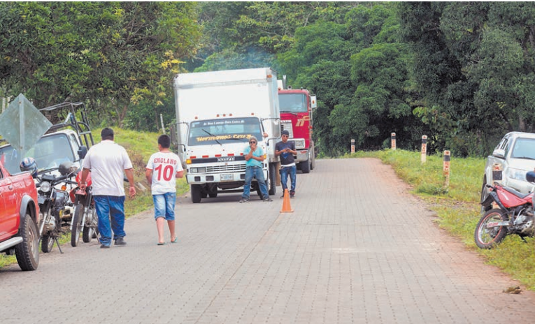
El MTI usó diez millones de dólares para construir 24,56 kilómetros de adoquinado. La obra busca cómo conectar Bluefields con el Pacífico.
