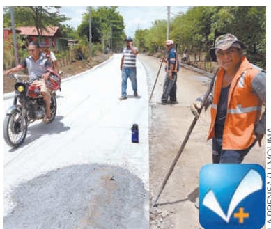
En abril iniciaron los trabajos en el camino Las Jagüitas.
