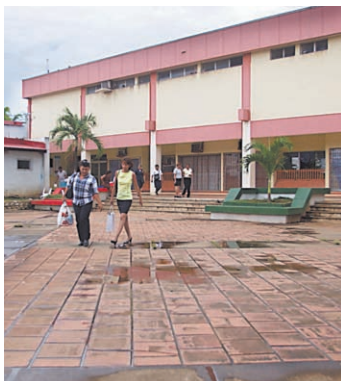
La CGR encontró anomalías en Hospital “La Mascota”.
