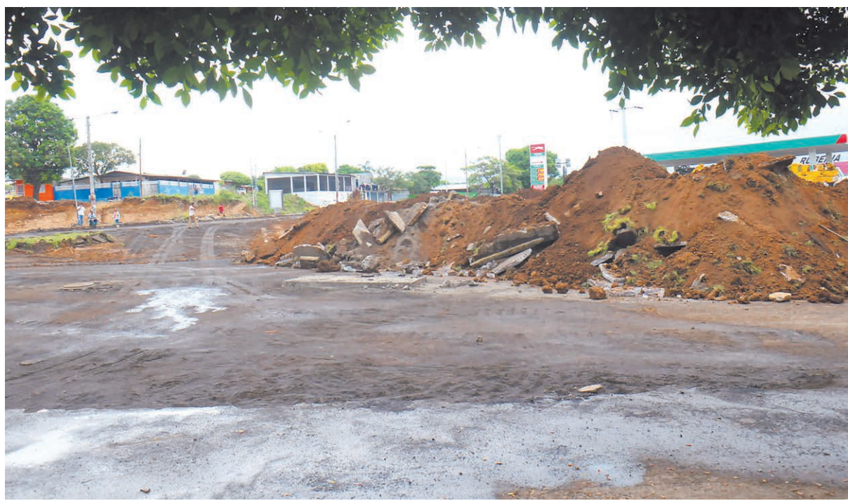
Los trabajos de la Alcaldía de Managua son incesantes para la construcción del paso a desnivel en Rubenia. Hoy se cumplen cinco días de labores.
