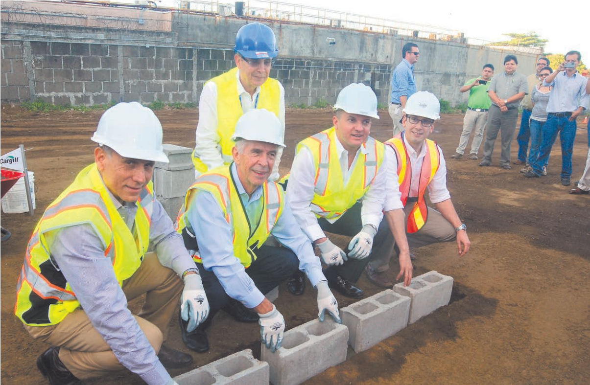
Representantes de Cargill y el delegado presidencial para las inversiones, Álvaro Baltodano, colocaron la primera piedra del nuevo complejo industrial de la empresa que le permitirá modernizar sus procesos.
