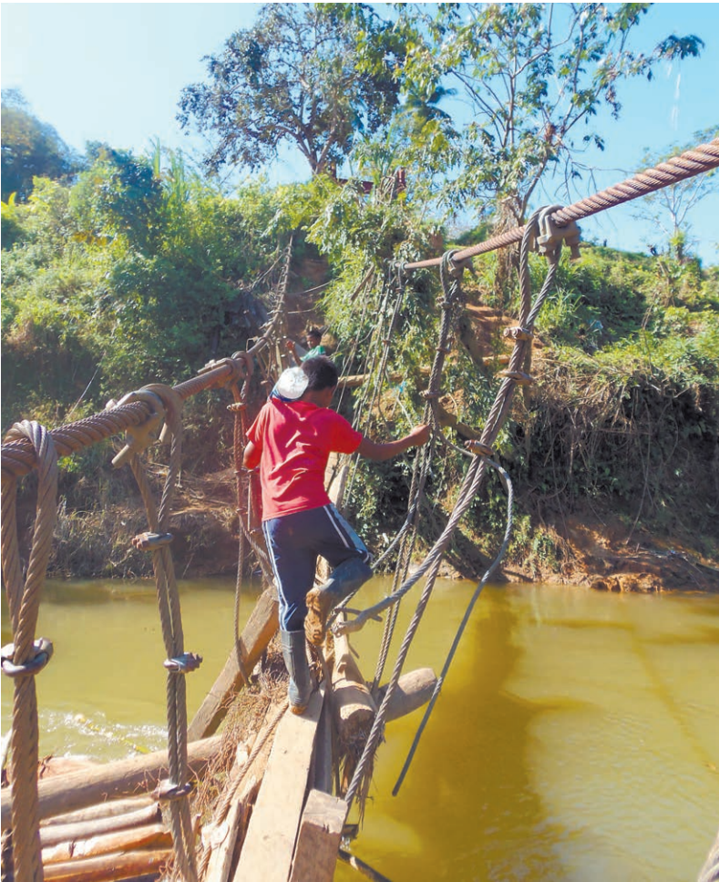
En una crecida el río Bambana se llevó parte del puente colgante.
