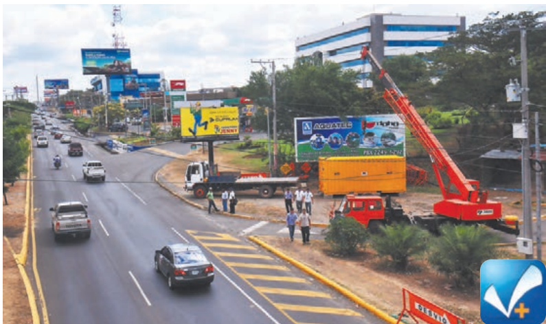
Ayer una grúa del MTI llevó un contenedor, donde guardarán herramientas para la obra; la puesta no ocasionó caos vehicular.
