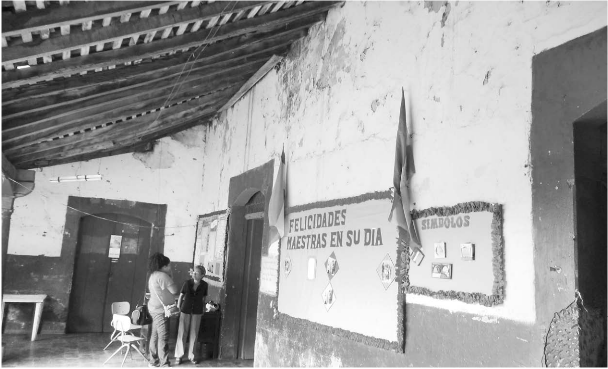
Las instalaciones donde funciona la Escuela San Sebastián son propiedad privada y desde hace años el Ministerio de Educación alquila el local, sin embargo no se ha hecho ningún tipo de inversión.
