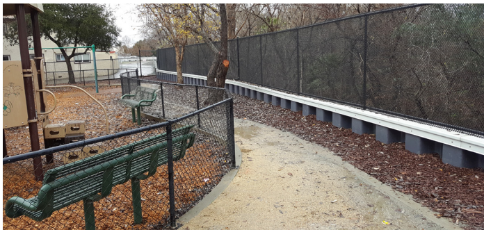
Bờ đất, tương tự như rào chắn lũ, đã được lắp đặt tại Công viên Rock Springs nhằm giảm thiểu các nguy cơ lũ lụt trong tương lai.
