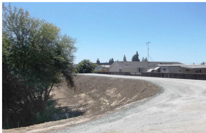
Sửa chữa đê phía sau Công viên Nhà Di động Golden Wheel.
